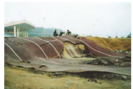
1999年台湾集集大地震(M7.7)で出現した逆断層鉛直方向に約2mのずれが生じた小学校のグラウンド
