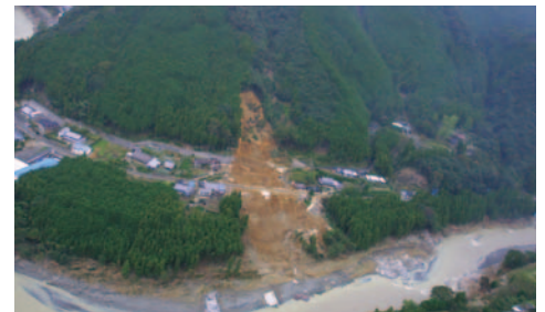
平成16年豪雨災害(旧宮川村 地内)
